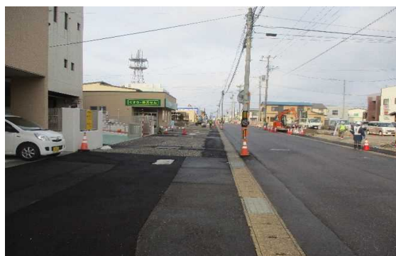
【進捗状況】 停車場栄町線(由利本荘市)
