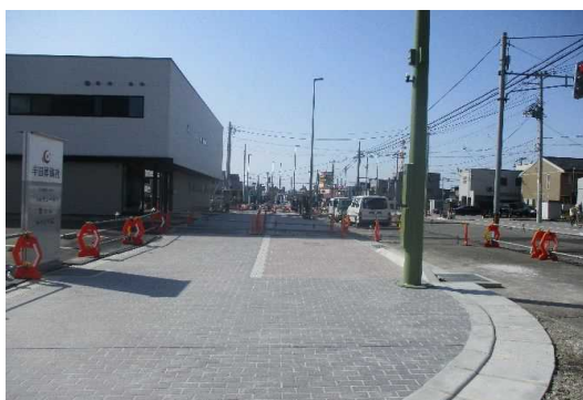
【進捗状況】 川尻広面線(秋田市)
